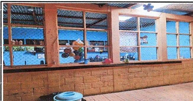
CERRAMIENTO DE VENTANAS CON LEVANTADO DE MURO DE BLOCK
