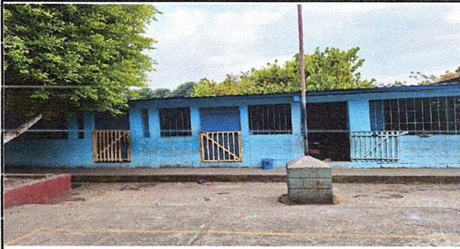
LEVANTO DE MURO DE BOLCK + REFUERZO DE COLUMNA DE CONCRETO PARA ELEVAR EL NIVEL DE TECHO Y SU PENDIENTE
