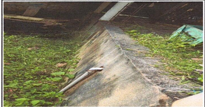
Cerco o muro perimetral
