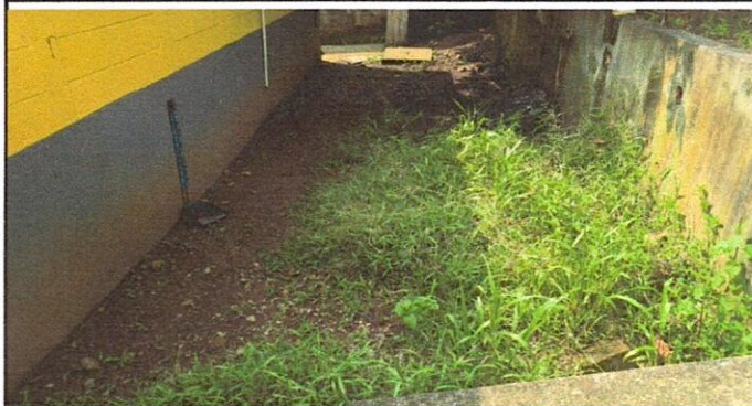
Suministro de losa de patio espesor 0.08 mts
