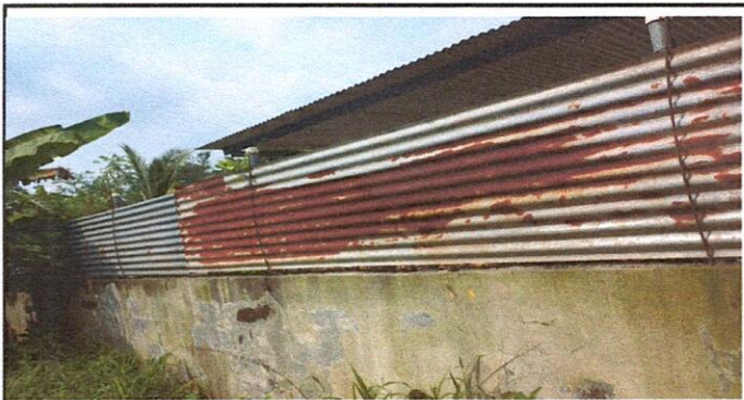
Cerco o muro perimetral
