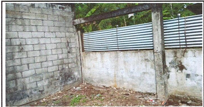
Cerco o muro perimetral
