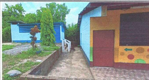
Suministro de lámina troquelada calibre 26 y suministro de estructura metálica de soporte para techo de lámina
