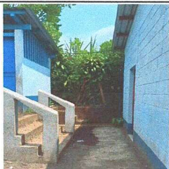
Suministro de piso cerámico en área de lavamanos y pila.
