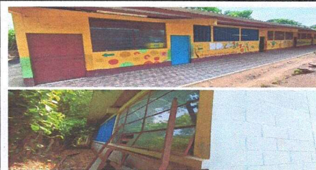
Sustitución de vidrios rotos por vidrio nevado de 5 mm
