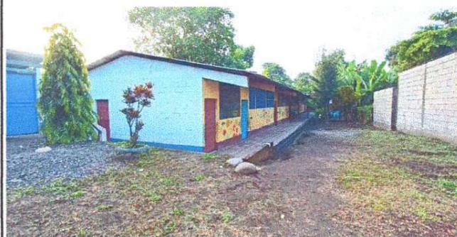
Pintura en muros exteriores e interiores.
