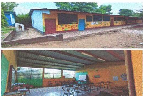
Sustitución de lámparas tipo candela por foco ahorrador en 4 aulas y corredores.
