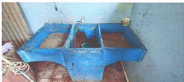
Suministro de azulejo en pila existente.
