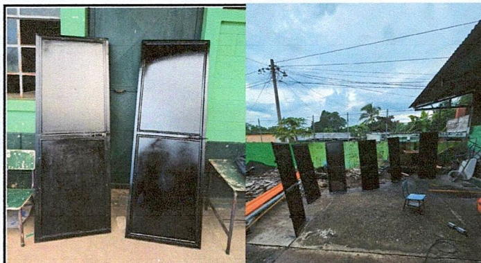
Foto 3: Mantenimiento de 7 puertas en el interior de los sanitarios de hombres y mujeres: 1.75 m de largo por 0.58 m de ancho; lijado, cepillado y aplicación de pintura.
