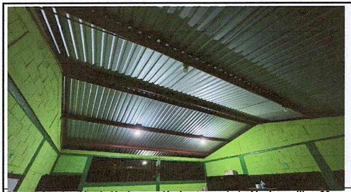
Foto 5: Sustitución de lámina por lámina troquelada Aluzinc calibre 26 LEG (0.40 mm), incluye capotes. Mantenimiento de 8 costaneras : lijado, cepillar y aplicar pintura; y sustitución de una costanera 7" x 2".
