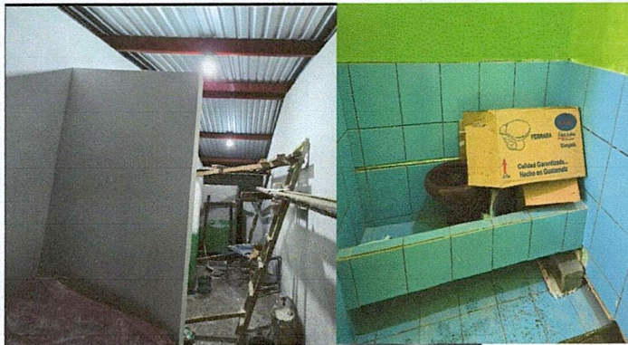
Foto 1: Sanitarios hombres: suministro de mesón con azulejo de 2.10 m de largo y 0.50 m de ancho: con 3 lavamanos; suministro de mingitorio: incluye azulejo tubo perforado y llave de paso: 1.92 m de largo y 0.50 m de ancho. Sustitución de piso de granito por piso cerámico; suministro de azulejo h:1.00 m, en el interior de los sanitarios. Repello y cernido de las paredes.
