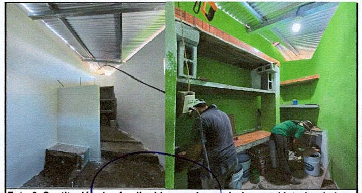
Foto 6: Sustitución de piso líquido por piso cerámico en el interior de la cocina. Repello y cernido de las paredes del interior de la cocina.
