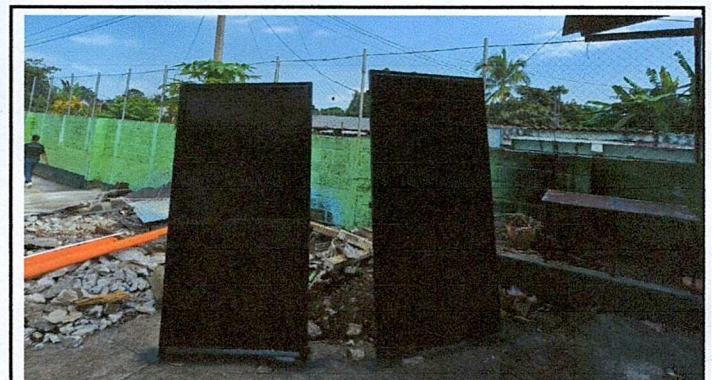
Foto 4: Mantenimiento de las 2 puertas de ingreso al servicio sanitarios de los hombres y mujeres: 1.93 m de largo por 0.98 m de ancho; lijado, cepillado y aplicación de pintura.
