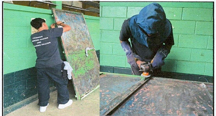
Foto 4: Mantenimiento de las 2 puertas de ingreso al servicio sanitarios de los hombres y mujeres: 1.93 m de largo por 0.98 m de ancho; lijado, cepillado y aplicación de pintura.
