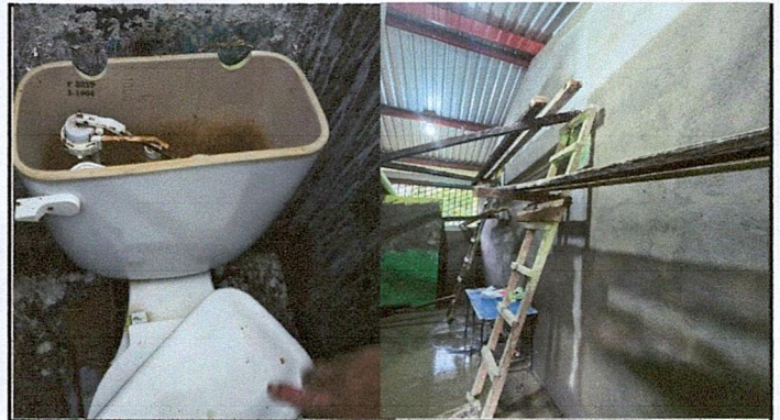
Foto 2: Sanitario de mujeres: suministro de mesón con azulejo de 2.10 m de largo y 0.50 m de ancho: con 3 lavamanos. Sustitución de piso de granito por piso cerámico. Suministro de azulejo h:1.00 m, en el interior de los sanitarios; sustitución de inodoro con sus accesorios. Repello y cernido de las paredes.
