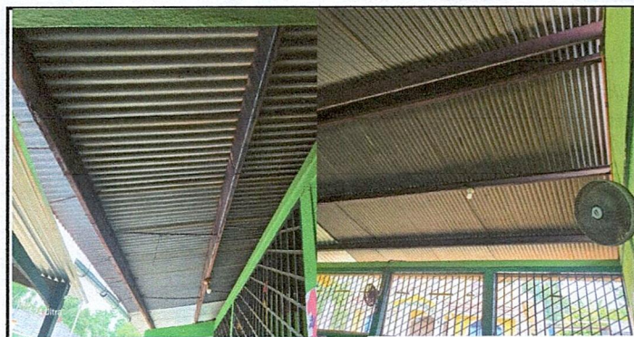
Foto 5: Sustitución de lámina por lámina troquelada Aluzinc calibre 26 LEG (0.40 mm), incluye capotes. Mantenimiento de 8 costaneras: lijar, cepillar y aplicar pintura; y sustitución de una costanera 7" x 2".
