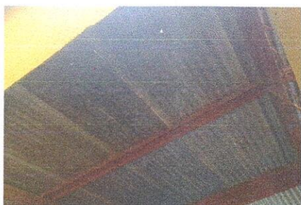
Foto 1: Sustrucción de estructura de soporte metal por metal costanera 2x3
