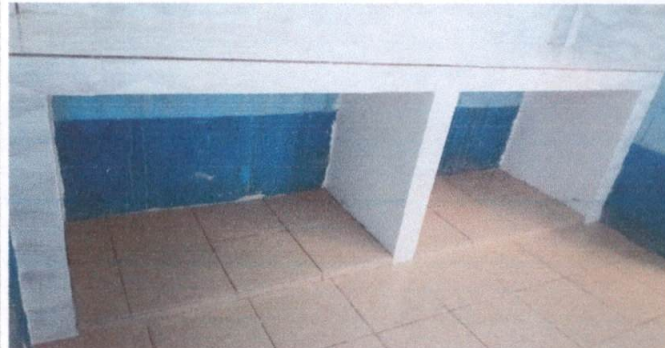
SUMINISTRO DE MUEBLE DE TRABAJO DE CONCRETO CON REVESTIMIENTO DE AZULEJO DE 2.30X.06X0.90 EN BODEGA
