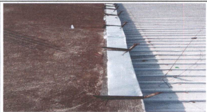
REPARACIÓN DE CANALES Y BAJADAS
