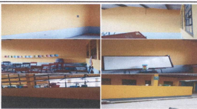
APLICACIÓN DE PINTURA EN MUROS INTERIORES DE AULAS
