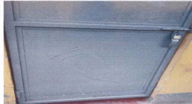
REPARACIÓN DE PUERTAS DE SERVICIOS SANITARIOS DE 1.90X0.70 MTS (INCLUYE LIJADO MAS APLICACIÓN DE PINTURA)
