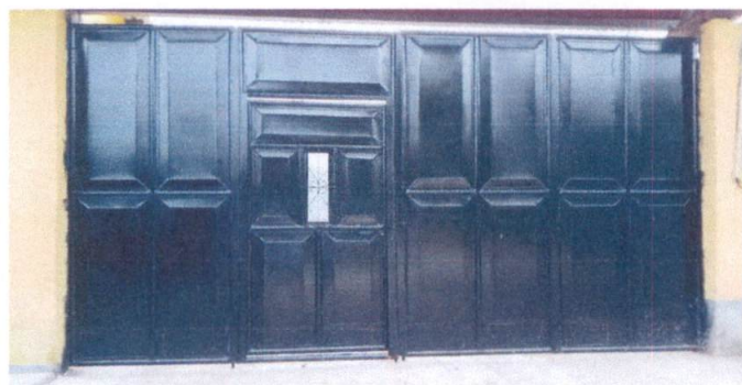
REPARACIÓN Y MANTENIMIENTO A PORTÓN DE 4.65X2.60 MTS (INCLUYE CEPILLADO LIJADO CAMBIO DE MARCO DE PORTON +APLIACIÓN DE PINTURA)
