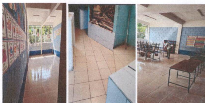
SUSTITUCIÓN DE PISO DE TORTA POR PISO CERAMICO EN AULAS DIRECCION Y BODEGA)
