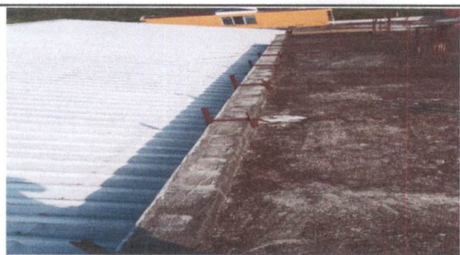
REPARACIÓN DE CANALES Y BAJADAS
