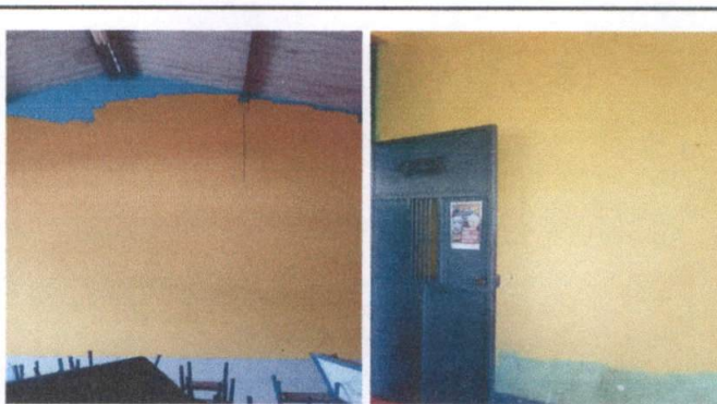
APLICACIÓN DE PINTURA EN MUROS INTERIORES DE AULAS
