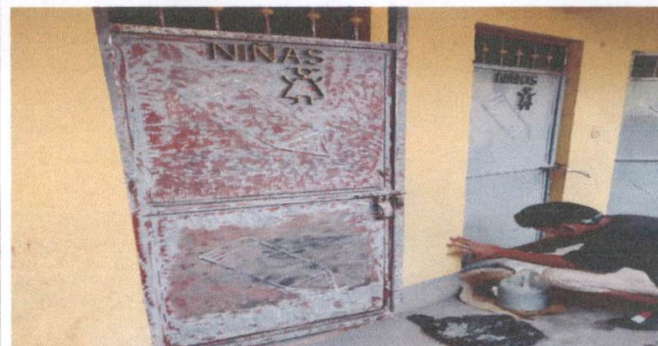
REPARACION DE PUERTAS DE SERVICIOS SANITARIOS DE 1.90X0.70 MTS (INCLUYE LIJADO MAS APLICACIÓN DE PINTURA)
