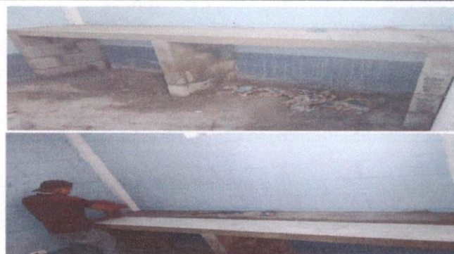
SUMINISTRO DE MUEBLE DE TRABAJO DE CONCRETO CON REVESTIMIENTO DE AZULEJO DE 2.30X.06X0.90 EN BODEGA
