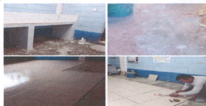
SUSTITUCIÓN DE PISO DE TORTA POR PISO CERAMICO EN AULAS DIRECCION Y BODEGA)
