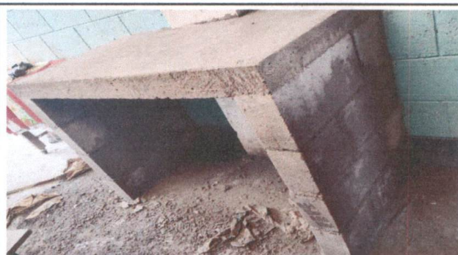
SUMINISTRO DE MUEBLE DE TRABAJO DE CONCRETO + REVESTIMIENTO DE AZULEJO DE 1.20X0.62X0.85 MTS
