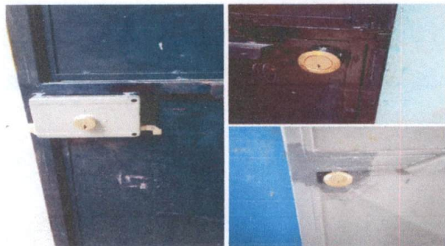
SUSTITUCIÓN DE CHAPAS DE PUERTAS EN AULAS INCLUYE INSTALACIÓN
