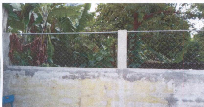
SUMINISTRO DE SOLERA DE CONCRETO SOBRE MURO PERIMETRAL PARA EMPOTRAR MALLA GALVANIZADA
