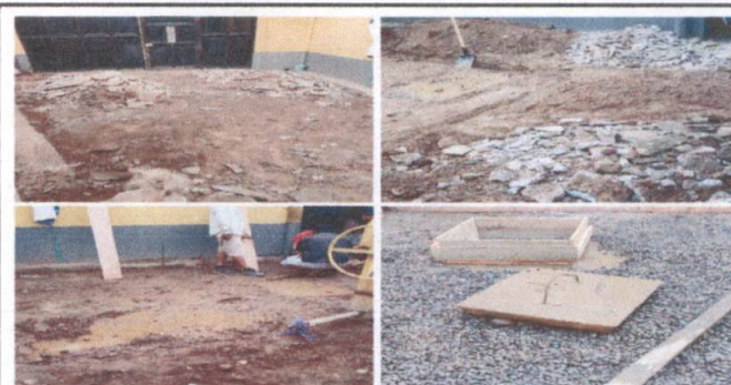
REPARACIÓN DE LOSA DE PATIO EN AREA DE INGRESO AL ESTABLECIMIENTO
