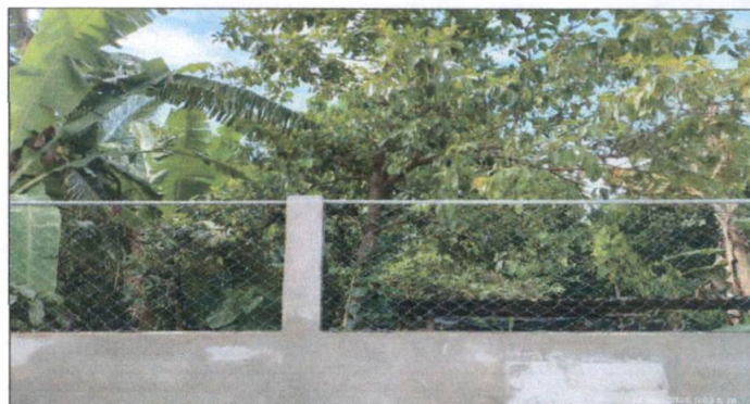
Foto 4: SE REDALIZARA UNA SOLEREA DE CONCRETO PARA FUNDIR MALLA GALVANIZADA
