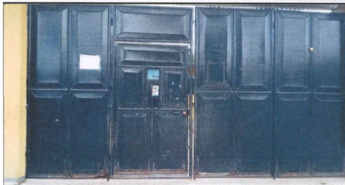
Foto 2: REPARACIÓN Y MANTENIMIENTO A PORTÓN PRINCIPAL DEL ESTABLECIMIENTO SE REALIZARA CAMBIO DE LAMIN AEN MALESTADO MÁS MARCO DE TUBO
