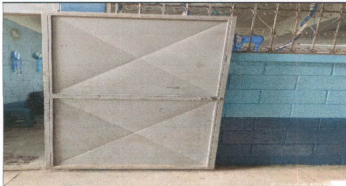
Foto1: INSTALACION DE CHAPAS EN PUERTAS DE AULAS Y MANTENIMIENTO A PUERTAS DE SERVICIOS SANITARIOS
