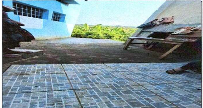
Foto 2: Referencia renglón 2.1 Instalación de piso cerámico antideslizante en corredor de cocina
