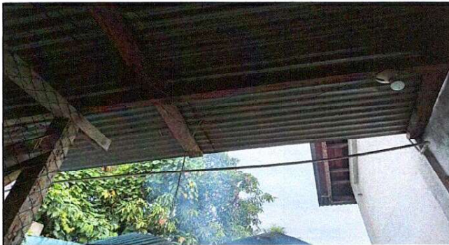
Foto 3: Referencia renglón 3.1 Sustitución de lámina, por lámina troquelada aluzinc calibre 26
