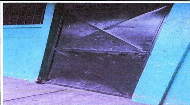
Foto 1: Referencia renglón 1.1 (sustitución de puertas de metal con su respectiva chapa, incluye mano de obra e instalación).
