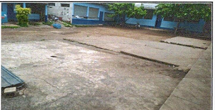
FOTO 5: LOSA DE CONCRETO
