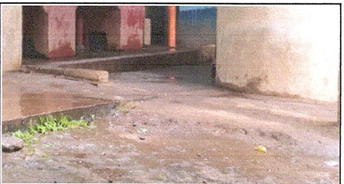
FOTO 4: SUSTITUCION DE CAJA DE REGISTRO DE PILA
