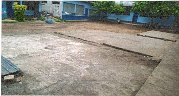
FOTO1: SUMINISTRO DE LOSA DE CONCRETO
