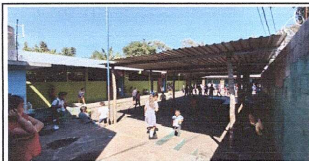
Foto 5: Sustitución de losa de patio de concreto y adoquín
