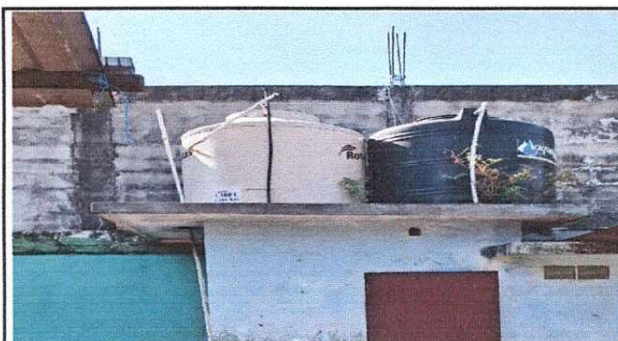
Foto 3: Sustitución de depósito de agua 1100 litros de polietileno.
