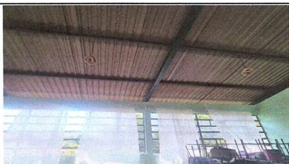
Foto 5: Las plafoneras han sufrido un deterioro significativo, lo que ha afectado su capacidad para cumplir su función, y ya no son operativas.
