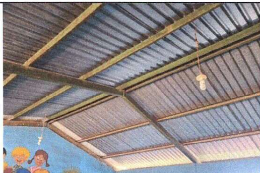
Foto 9: El uso de ducto es imprescindible para asegurar la integridad y durabilidad del sistema eléctrico.
