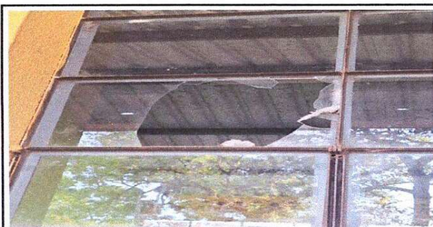
Foto 5: Sustitución de vidrios
