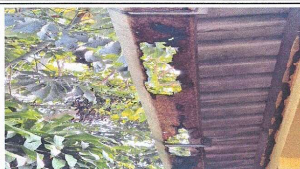
Foto 2: Sustitución de canal metal por metal y bajadas de agua pluvial
