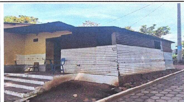
Foto 4: Sustitución de techo y cubierta de lámina
