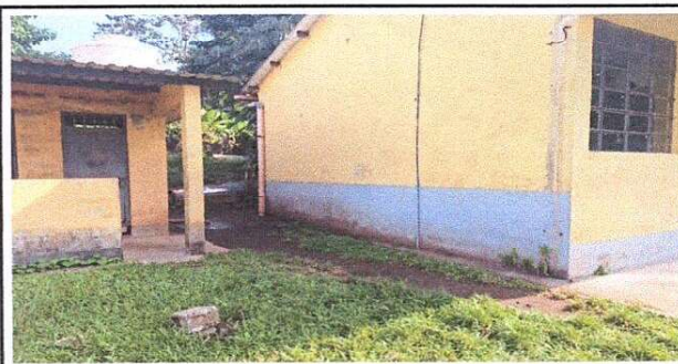
Foto 6: Suministro de losa de patio y suministro de cubierta de lámina
