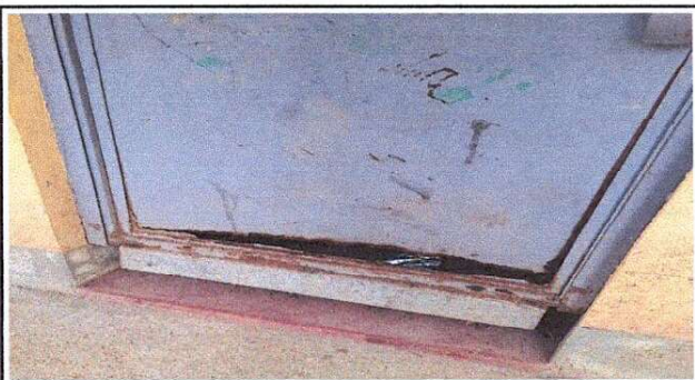
Foto 3: Mantenimiento de puertas de metal
