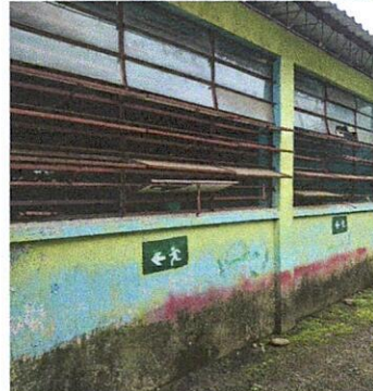
Foto 2: Referencia renglón 1.2 (Sustitución de vidrio por vidrio en ventas 0.30 x 0.75 vidrio claro 5mm (incluye pago de mano de obra))
