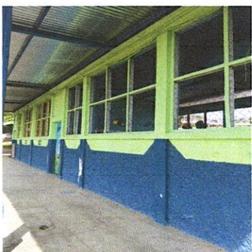
Foto 3: Referencia renglón 2.1 (Suministro e instalación de balcón metálico con marco de 1" x 1", tubos cuadrado 3/4" reforzado con plano de 3/4" x 1/8" (incluye pago de mano de obra))
