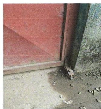
Foto 4: Referencia renglón 3.1 (Mantenimiento a puerta, lijado, cepillado y pintado 1.00 x 2.00 (incluye pago de mano de obra))
