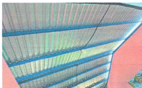
Foto 6: REFERENCIA RENGLO 1.3 (MANTENIMIENTO DE COSTANERAS Y VIGAS DE METAL DE SOPORTE DE TECHO)
