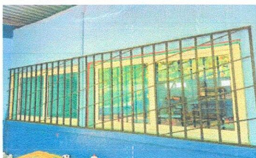
Foto 5: SUMINISTRO DE VENTANA DE PVC
