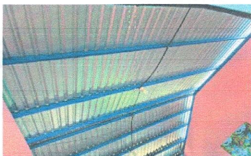
Foto 3: REFERENCIA RENGLO 1.5 (SUSTITUCIÓN DE LAMPARAS 2 X 40 POR FOCOS LED)
