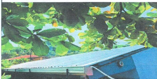
Foto 1: REFERENCIA RENGLO 1.1 CAMBIO DE LAMINA TROQUELADA ALUZINC CALI BRE 26
