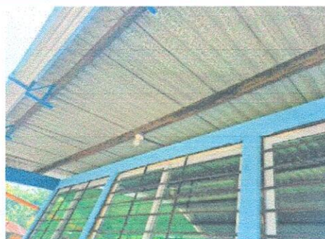
Foto 4: REFERENCIA RENGLO 1.2 (SUSTITUCIÓN DE CANALES DE PVC POR METAL)
