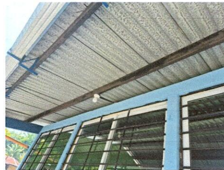
Foto 4: REFERENCIA RENGLO 1.2 (SUSTITUCIÓN DE CANALES DE PVC POR METAL)
