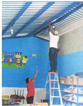
Foto 3: REFERENCIA RENGLO 1.5 (SUSTITUCIÓN DE LAMPARAS 2 X 40 POR FOCOS LED)
