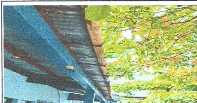
Foto 4: Referencia renglón 1.2 (Sustitución de canales de pvc por metal)
