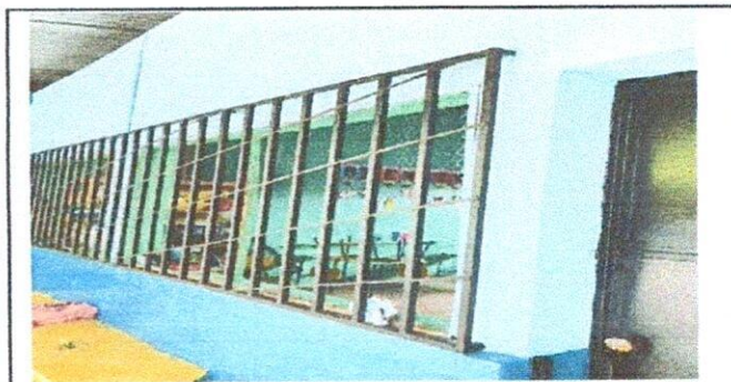
Foto 5: Suministro de ventana de pvc.
