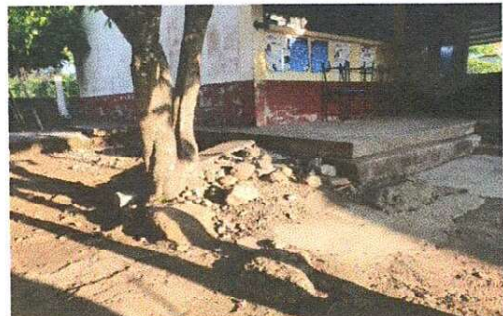
Losa de patio (36 m 2 de rampa). Fundición de rampas
