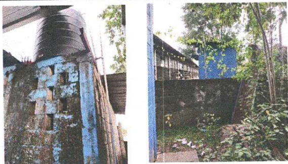
Reparación y mantenimiento de cisternas/depósito de agua.
