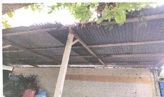
Sustitución, estructura de techo y cubierta de láminas.
