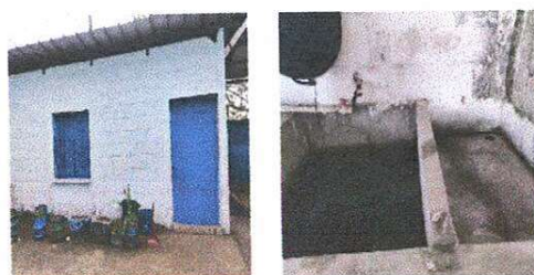
Reparación o sustitución de área de cocina.
