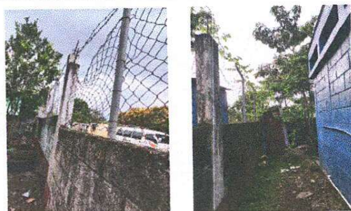
Cerco o Muro perimetral. Cambio de malla metálica de muro perimetral de módulo 1, frente a calle principal, atrás de la cocina y atrás de terna de baños.
