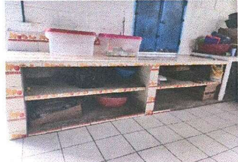
Puertas (para gabinete de cocina). Elaboración e instalación de dos puertas para gabinete medidas: 152 x 73 y 147 x 73.
