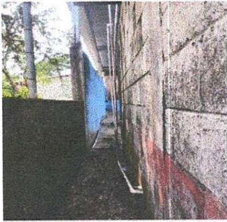
Reparación red de drenajes y red de agua potable.
