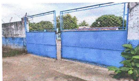
Mantenimiento a portones.
