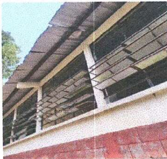
Cubierta de cinco láminas troqueladas de 2 aulas del módulo 2
