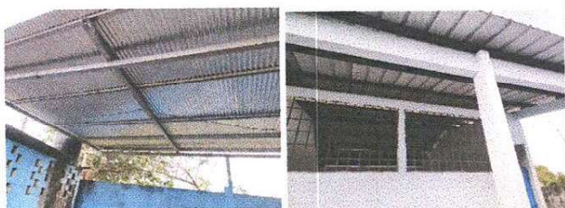
Sustitución de sistema eléctrico.
