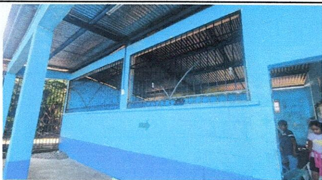
Foto 3: Se instalaron ventanas nuevas para mejorar la seguridad y la presentación del espacio.
