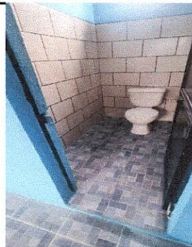
Foto 8: Ahora los baños cuentan con azulejo y piso adecuados, lo que facilita la limpieza y brinda un entorno más higiénico para los niños.
