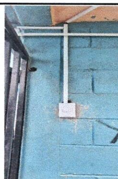
Foto 10: Se reemplazó el interruptor dañado, lo que garantiza una mayor seguridad para los niños.
