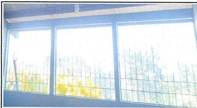
Foto 4: Se realizó mantenimiento a los balcones para garantizar su estabilidad y seguridad.
