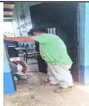
Foto 2: Se procedió a reemplazar la chapa para aumentar la seguridad y prevenir posibles incidentes de acceso no autorizado.
