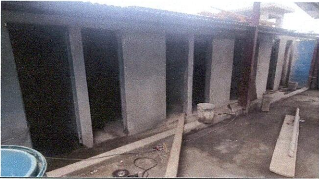
Foto 7: Se procedió a retirar las puertas para realizar mantenimiento, que incluyó cepillado y pintado, devolviéndoles su aspecto original y prolongando su durabilidad.
