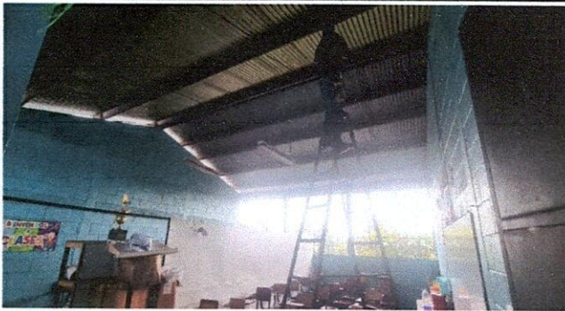
Foto 9: Se reemplazaron las lámparas antiguas por nuevas, renovando la iluminación del espacio.
