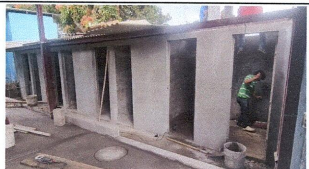
Foto 12: Se repallaron los muros interiores y exteriores de los sanitarios para facilitar la limpieza.
