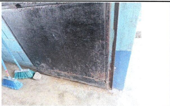
Foto 1: Se procedió a reparar la puerta para garantizar una mayor seguridad y prevenir posibles incidentes.
