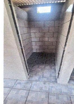
Foto 8: Se instaló azulejo y piso antideslizante en los baños para mayor seguridad y facilidad de limpieza.
