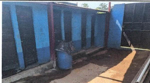
Foto 12: Aplicación de repello en muros
