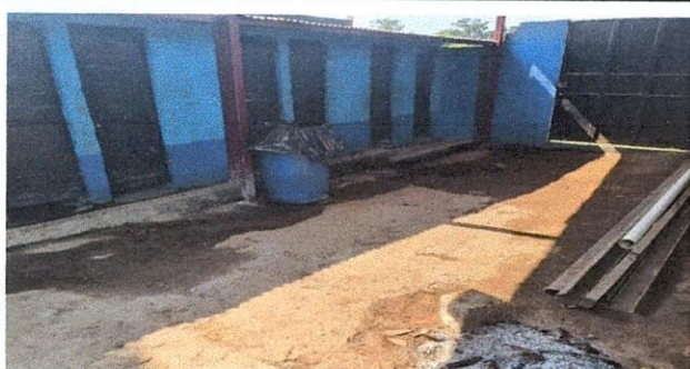
Foto 11: Suministro de depósito de agua 1000 lt
