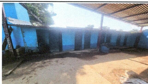
Foto 6: Pintura en muros exteriores e interiores
