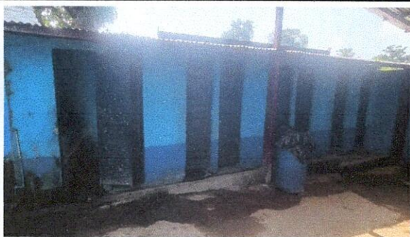
Foto 7: Mantenimiento a puertas de metal
