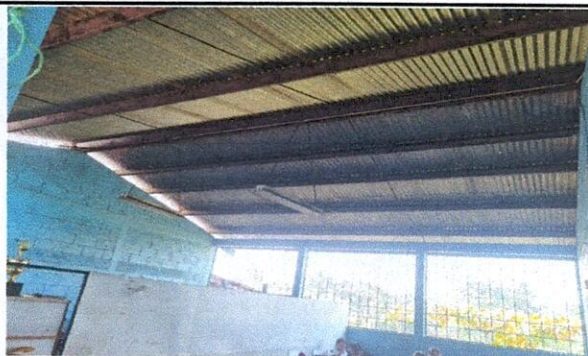
Foto 9: Sustitución de lámparas.
