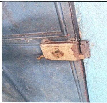
Foto 2: Sustitución de chapa
