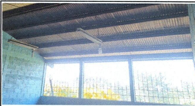
Foto 4: Mantenimiento a balcones de metal
