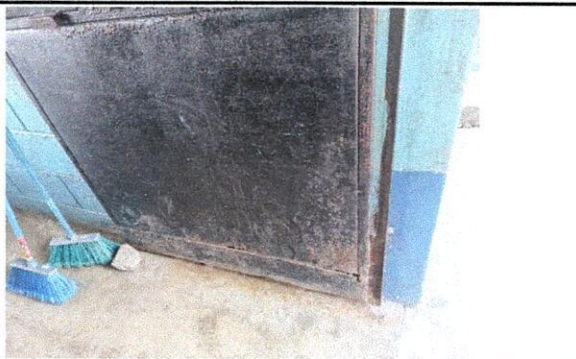
Foto 1: Mantenimiento de estructura
