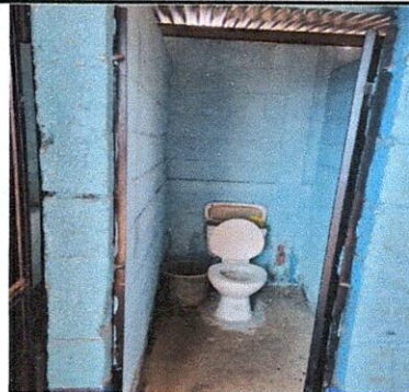
Foto 8: Reparación o sustitución de azulejos en los baños.
