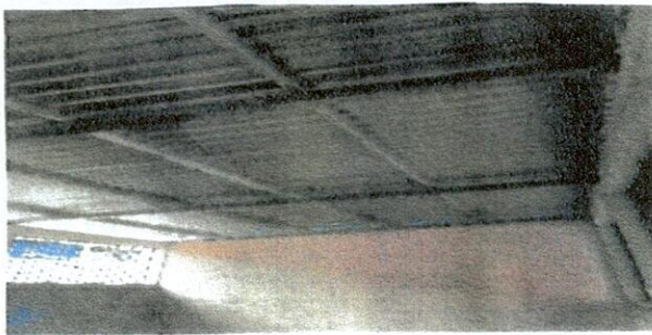
Foto 5: Sustrucción de lámina por lámina aluzinc en aula
