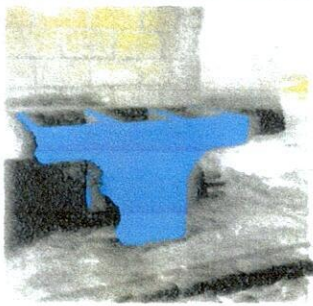
Foto 1: Sustrucción de pila de 2 lavaderos
