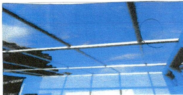
Foto 4: Sustrucción de estructura de madera por costanera
