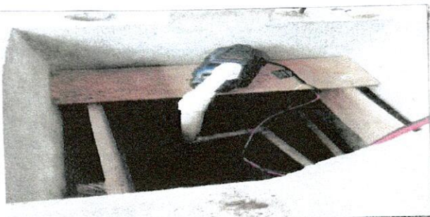
Foto1: Suministro de bomba para agua 1hp
