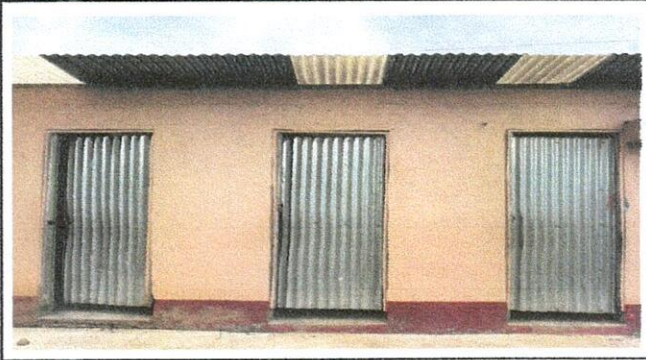
Foto 2: Sustitución de puertas en aula. Ver Acta No. 19-2025
