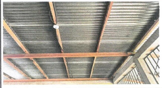
Foto 4: Sustitución de estructura de madera por costanera
