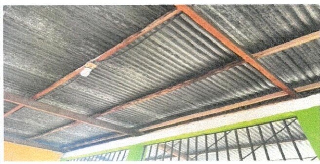
Foto 5: Sustitución de lámina por lámina aluzinc en aula
