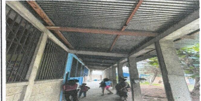
Foto 6: Suministro de pintura
