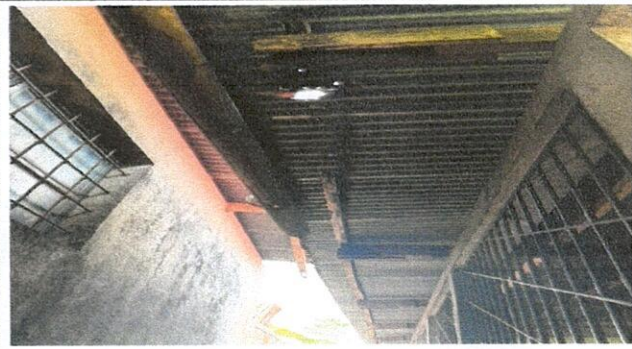
Foto 3: Sustitución de lámina por lámina aluzinc en corredor
