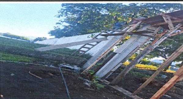
Foto 5: Referencia renglón 1.11 (Suministro para conformación de plataforma y fundición de gradas)
