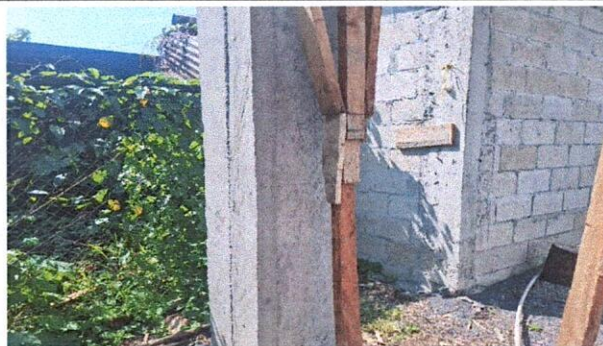
Foto 4: Referencia de renglón 1.10 (suministro para muro de cerramiento)
