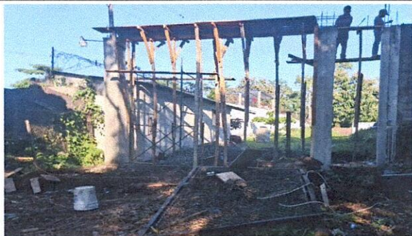
Foto 1: Referencia renglón 1.1, 1.2, 1.3, 1.5, 1.6 y 1.7 (suministro para columnas vigas y losa).
