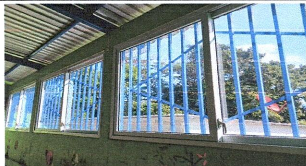
FOTO 2: SUSTITUCIÓN DE VENTANAS
