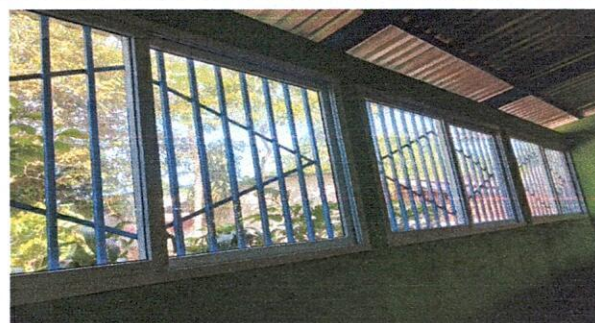
FOTO 6: SUSTITUCION DE VENTANAS
