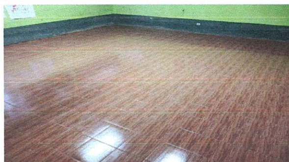
FOTO 4: SUSRIRUCIÓN DE PISO
