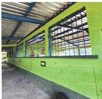
FOTO 3: MANTENIMIENTO DE BALCONES
