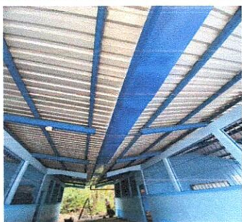
FOTO 5: SUSTITUCION DE CANAL
