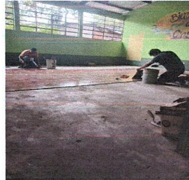
FOTO 4: SUSTITUCIÓN DE PISO
