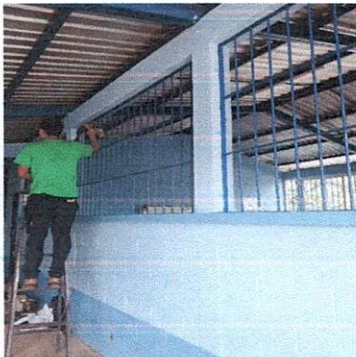
FOTO 3: MANTENIMIENTO DE BALCONES
