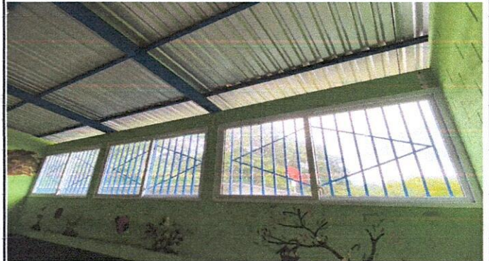
FOTO 2: SUSTITUCIÓN DE VENTANAS
