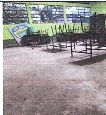
Foto 4: SUSTITUCIÓN DE PISO
