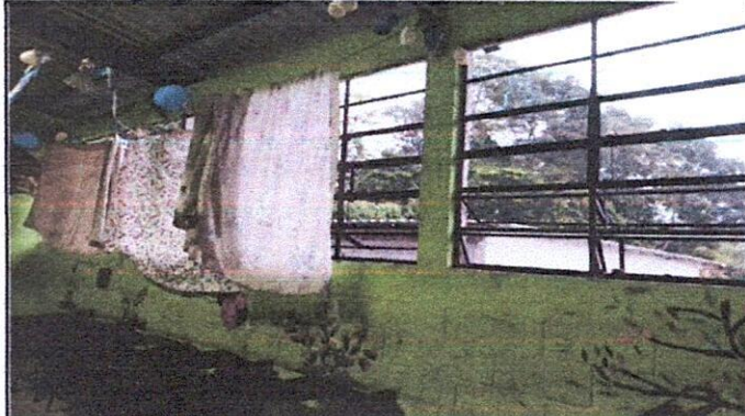
Foto 2: SUSTITUCIÓN DE VENTANAS
