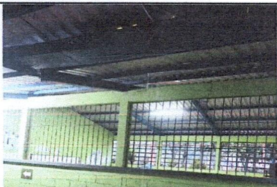
Foto 5: SUSTITUCIÓN DE CANAL
