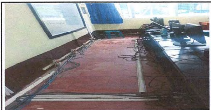
Foto 5: Sustitución de Piso
