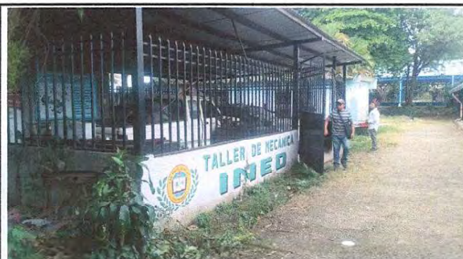
Foto 15: MANTENIMIENTO DE BARANDAS
