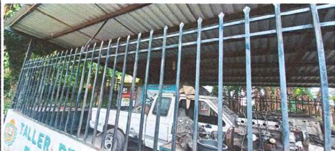
Foto 13: MANTENIMIENTO DE BARANDAS
