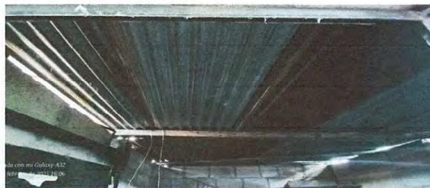
Foto 10: ESTRUCTURA DE TECHO sustitución de estructura de soporte de madera por metal
