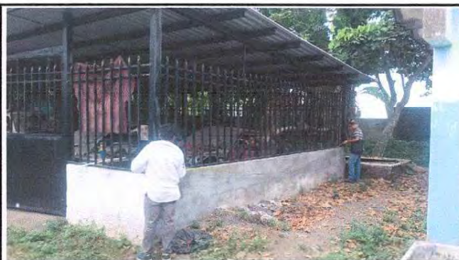
Foto 16: MANTENIMIENTO DE BARANDAS
