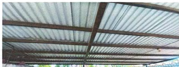
Foto 9: ESTRUCTURA DE TECHO mantenimiento a estructura de soporte de metal
