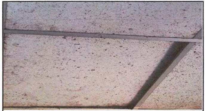
Foto 4: SUSTITUCIÓN DE CIELO FALSO
