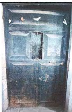
Foto 11: PUERTA DE METAL mantenimiento a estructura y cambio de chapa
