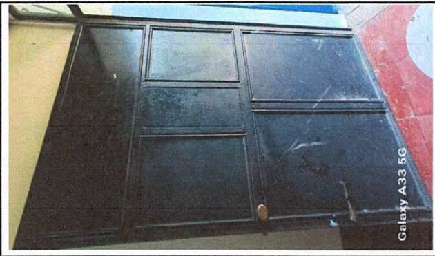
Foto 2: PUERTA DE METAL AULA COMPUTACIÓN
