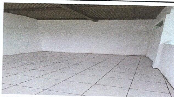
Foto 6: Sustitución de piso de concreto por piso cerámico
