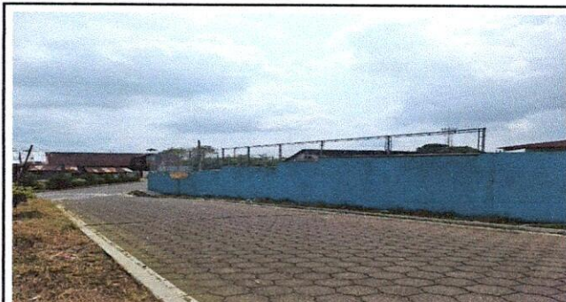
Foto 12. Reparación de tubo Hg y malla galvanizada
