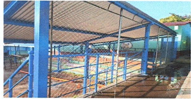
Foto 8. Mantenimiento a barandas de metal
