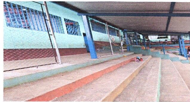
Foto 9: Mantenimiento de barandas de metal
