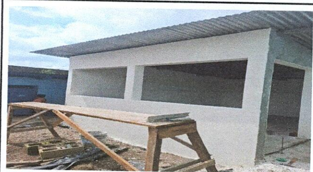
Foto 4: Suministro de repello y cernido
