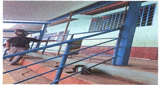
Foto 8: Mantenimiento a barandas de metal
