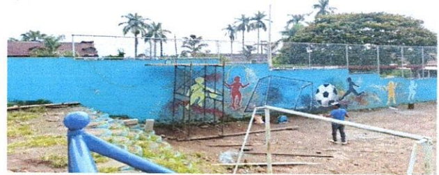
Foto 12: Reparación de tubo Hg y malla galvanizada
