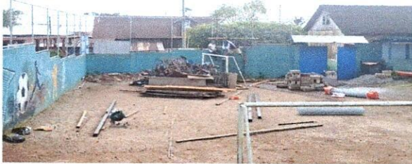
Foto 11: Reparación de tubo Hg y malla galvanizada
