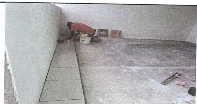
Foto 6: Suministro de piso de concreto por piso cerámico
