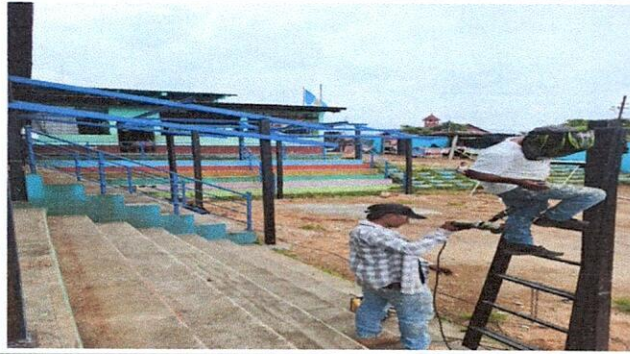
Foto 7: Sustitución de estructura y cubierta de lámina
