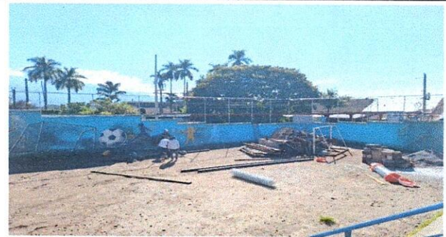
Foto 10: Reparación de tubos Hg y malla galvanizada
