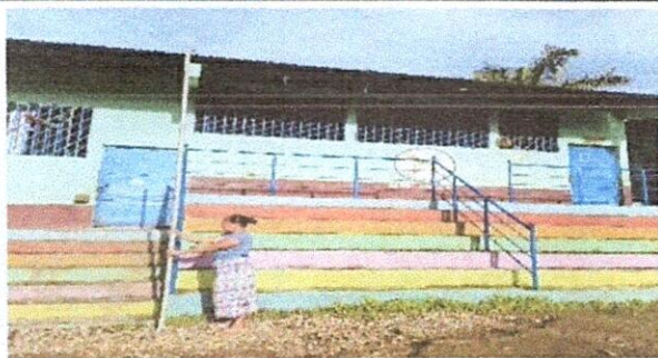
FOTO 7: Sustrucción de estructura y cubierta de lámina
