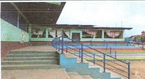
FOTO 9: Mantenimiento de barandas de metal
