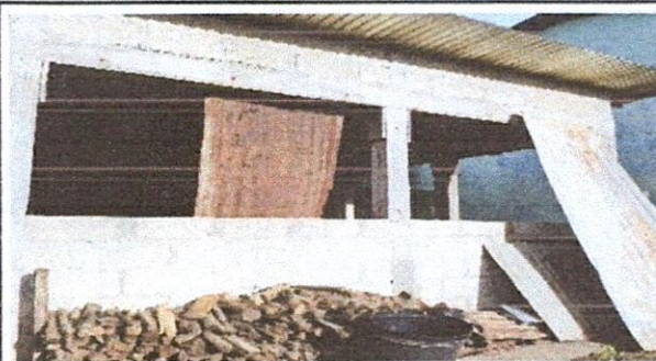
FOTO 2: Suministro de balcones de metal
