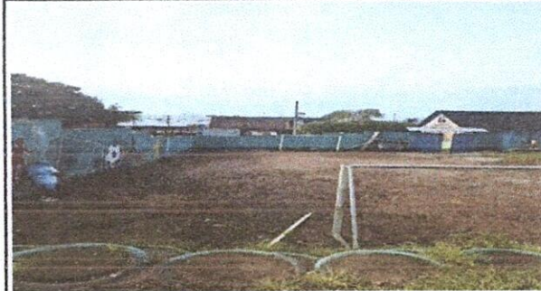
FOTO 10: Reparación de tubos Hg y malla galvanizada
