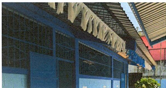
Foto 3: Instalación de balcones en su totalidad
