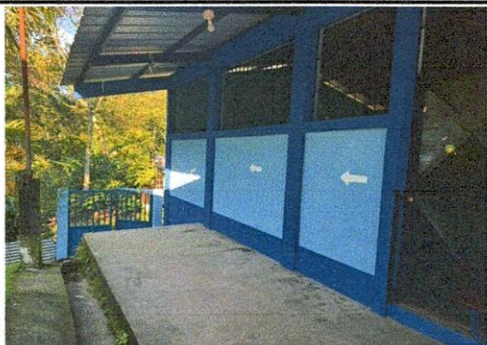
Foto 1: Aplicación de pintura en muros exteriores e inferiores
