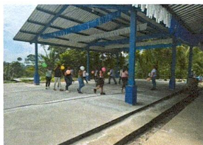
Foto 5: Fase final de la losa de patio
