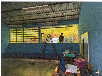
Foto 3: Instalación de balcones.
