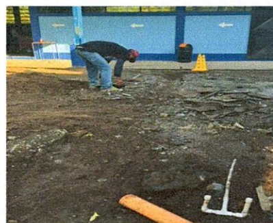
Foto 6: Aplanando el terreno para el trabajo .
