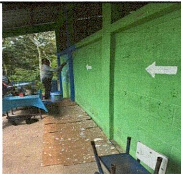
Foto1: Aplicación de pintura en muros exteriores e interiores
