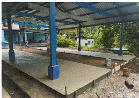
Foto 5: Hechura de losa de concreto en patio.
