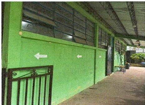
Foto1: Suministro de pintura muro exteriores e inferiores
