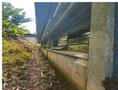
Foto 3: Instación de balcones
