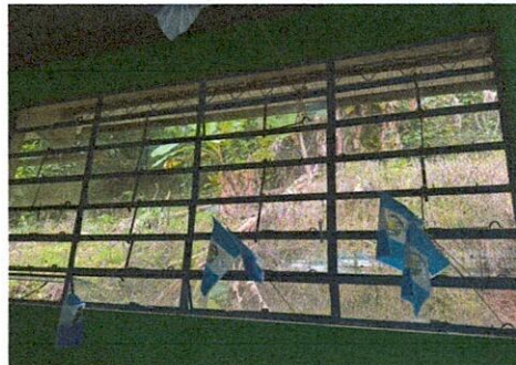
Foto 2: Sustitución de ventanas de vidrio po ventanas u-PVC
