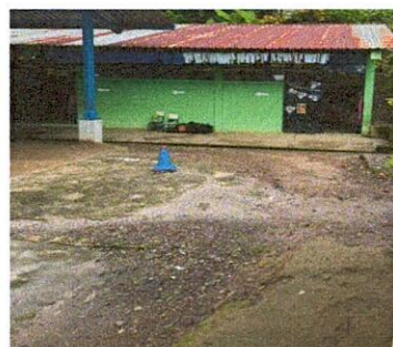
Foto 6: Aplanando el terreno para el trabajo .
