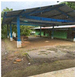
Foto 5: Suministro de concreto en losa de patio t:0.10 mts
