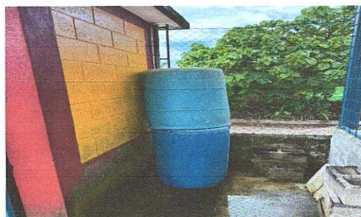
Foto 4: Suministro de mingitorio de concreto con azulejo 0.50 mts x 1.00 mts
