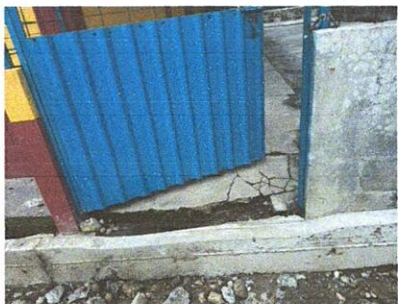
Foto 1: Suministro de concreto en piso en entrada al patio
