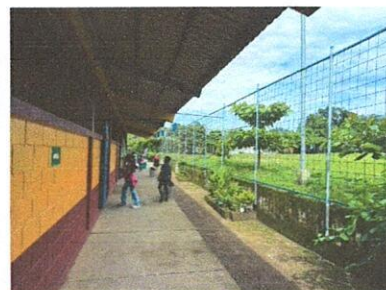
Foto 6: Suministro de repello en pared de block área patio (1.00 mts x 7.00 mts)
