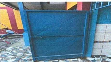
Foto 5: Mantenimiento de puertas de metal lijado, cepillado, aplicación de pintura anticorrosiva 0.80 mts x 2.00 mts (incluye pago de mano de obra)
