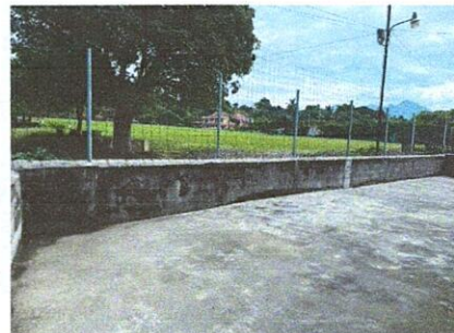
Foto 2: Sustitución de electromalla por malla galvanizada reforzado marco de metal 1 x 1 cha. 18 en área de patio 2.00 mts alto x 30.00 mts (incluye pago de mano de obra)
