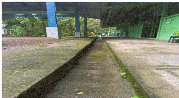
Foto 5: Reparación de cuneta de concreto 40 X 0.40 (incluye pago de mano de obra)
