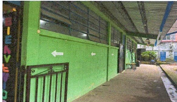
Foto 2: sustitución de ventanas de vidrio por ventanas u-pvc (incluye mano de obra)
