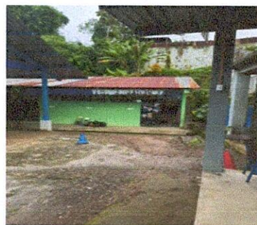
Foto 4: Sustitución de torta de concreto t:0.10
