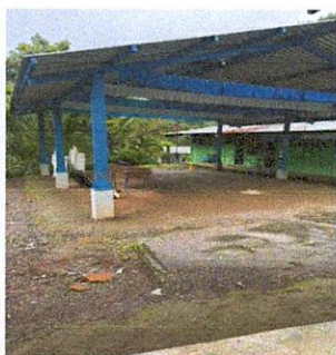
Foto 3: sustitución de canales de metal con canales de metal con abrazadera 3/4 x 3/4@0.75 mts (incluye mano de obra)
