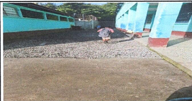
FOTO 1: Sustrucción de losa de patio
