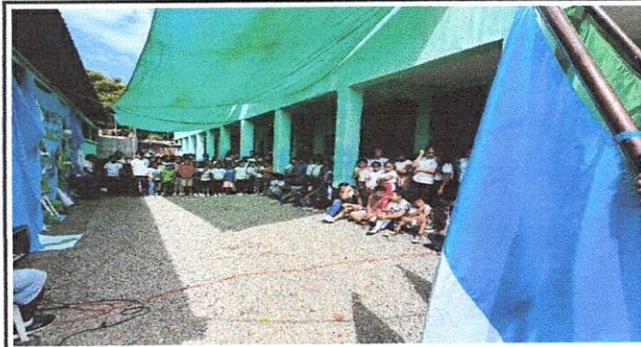
FOTO 4: Suministro de estructura de techo y cubierta de lámina
