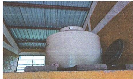
Foto 8: Sustrucción de accesorios en tinaco Válvula de check, llave de paso, reparación de tubo de abasto
