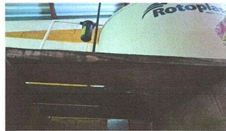
Foto 10: Sustrucción de base 1.50 x 1.50 x 0.40 de madera por base de tubo 3 x 3 cha.18 galvanizada (incluye pago de mano de obra)
