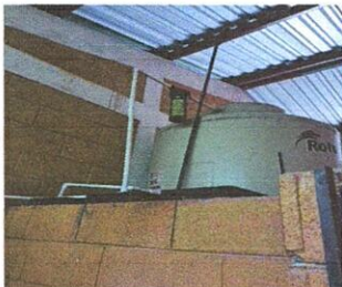
Foto 11: Sustrucción de base 1.50 x 1.50 x 0.40 de madera por base de tubo 3 x 3 cha.18 galvanizada (incluye pago de mano de obra)
