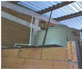
Foto 9: Reparación de sistema de agua de Rotoplas (tubos, check de paso de agua y accesorios)
