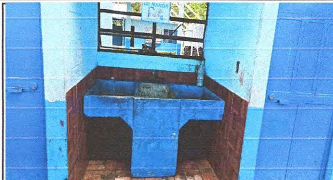
Foto 8: 4.2 Suministro de pila interior 1.55 x 0.80 x 0.85 de concreto de dos lavaderos incluye chorro
