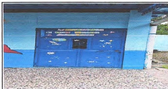
Foto 5: 2.1 Mantenimiento a puerta de metal 1.20x2.15 aulas incluye lijado, cepillado y aplicación de pintura anticorrosiva (incluye pago de mano de obra)
