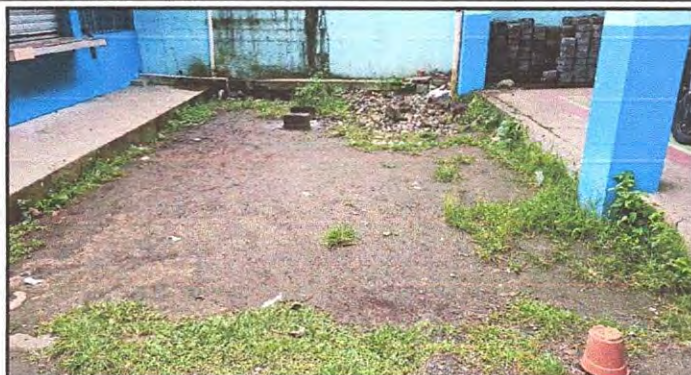
Foto 1: 1.1 Suministro de concreto área de cocina 5.00x6.00x0.10
