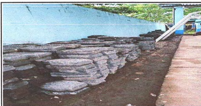
Foto 11: 1.4 Suministro de concreto t:0.10 (área de cancha, modulo sanitario y modulo 3)
