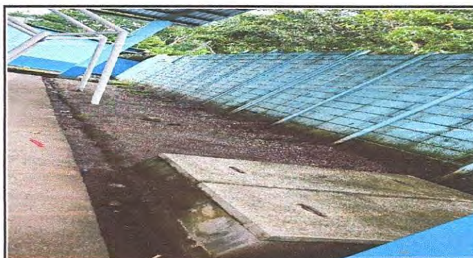
Foto 4: 1.4 Suministro de concreto t:0.10 (área de cancha, modulo sanitario y modulo 3)
