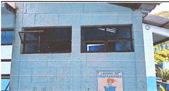
Foto 10: 4.4 Suministro de ventana 0.85x0.40 tipo sifón (incluye pago de mano de obra)
