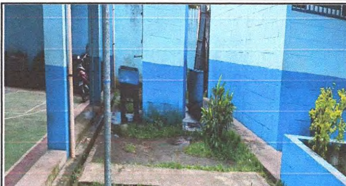
Foto 7: 4.1 Suministro de concreto t:0.10 (área de cancha, modulo sanitario y modulo 3)
