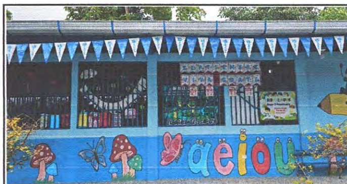
Foto 6: 3.1 Mantenimiento a balcones de metal 1.80x1.58 aulas incluye fijado, cepillado y aplicación de pintura anticorrosiva (incluye pago de mano de obra)
