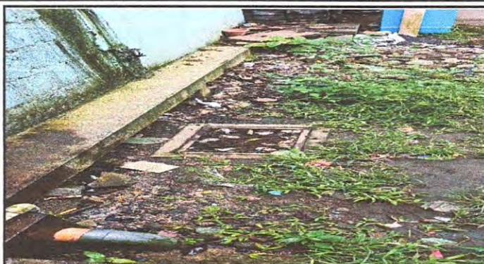
Foto 2: 1.2 Suministro de cuneta área de cocina 3.00x0.30x0.40 t:0.10 (Incluye trazo, zanqueo y fundición)
