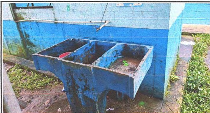
Foto 9: 4.3 Suministro de pila exterior 1.80 x 0.80 x 0.85 de concreto de dos lavaderos incluye chorro
