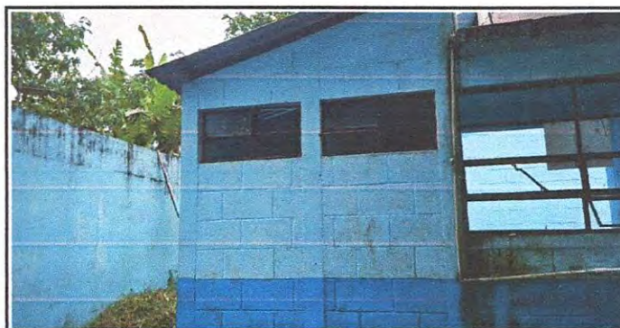
Foto 12: 4.4 Suministro de ventana 0.85x0.40 tipo sifón (incluye pago de mano de obra)
