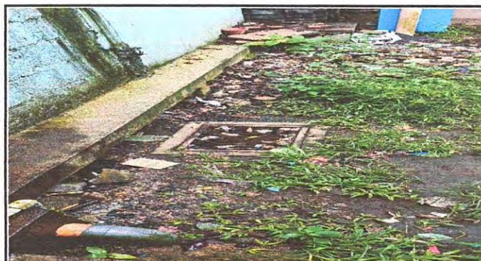
Foto 3: 1.3 Suministro e instalación de rejilla metálica área de cocina 3.00x0.30x0.40 con angular 3/4" x 3/4" mas plana de 3/4" (incluye pago de mano de obra)
