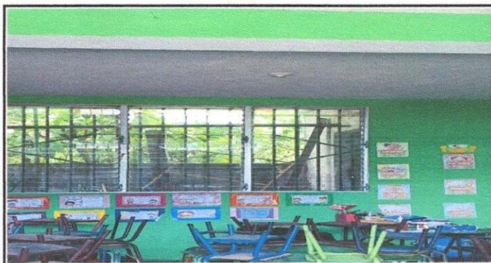
Foto 6: Sustrucción de sistema electrico (incluye 72 mts de cable, duco vinil, tonillo, vueltas PVC, cinta aislante, 12 plafoneras, 12 focos 50w, 4 interruptores simples, 12 tomacorrientes dobles).
