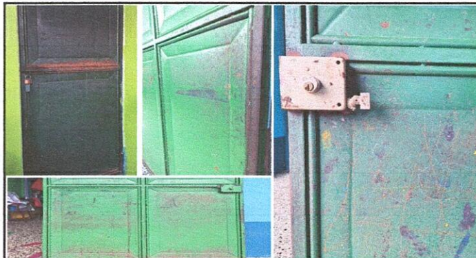
Foto 2: Mantenimiento a puerta de metal (lijado, cepillado, sujeciones, aplicación de pintura, incluye mano de obra). Sustrucción de chapa por chapa (incluye mano de obra).
