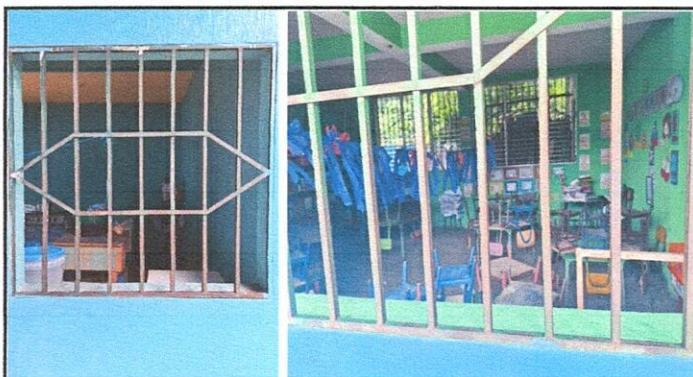
Foto 3: Mantenimiento balcones de metal (lijado, cepillado, sujeciones, aplicación de pintura, incluye mano de obra). Suministro e instalación de ventana mill finish vidrio de 5mm
