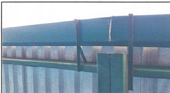
Foto 4: Sustrucción de soporte o pescantes de metal para canal (incluye pago de mano de obra).
