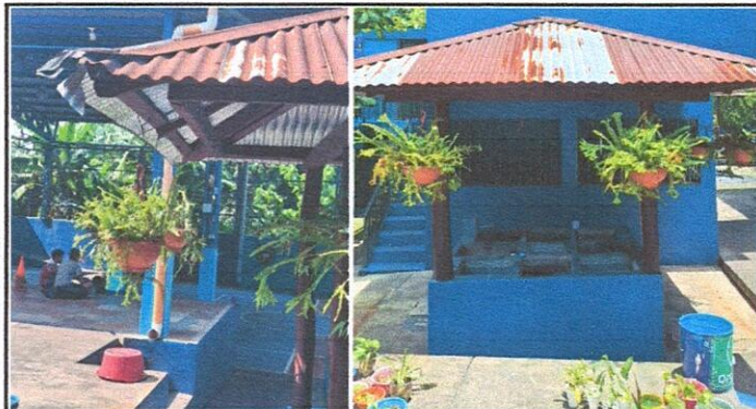
Foto 1: Sustrucción de estructura de soporte de madera por costanera 2" x 4"
