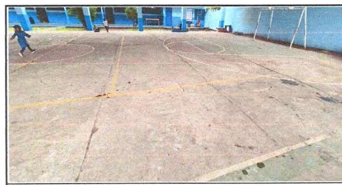
Foto 6: Reparación de torta de concreto
