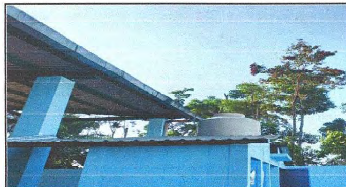
Foto 4: Suministro de lámina troquelada aluzinc calibre 26 como alero en sanitarios
