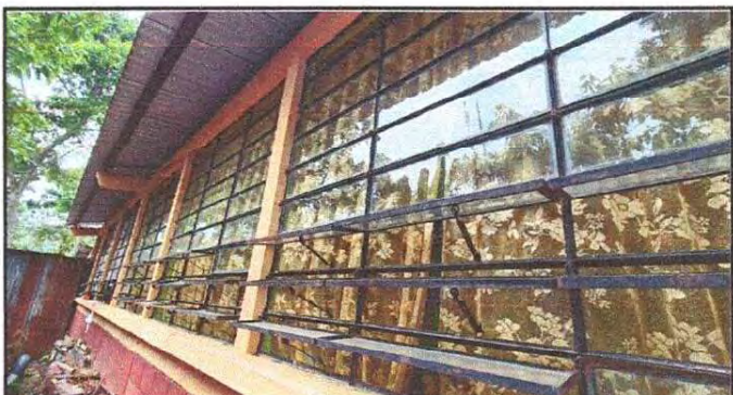
Foto 4: Sustitución de balcones de metal 2 unidades de 1.14 m x 1.38 m
