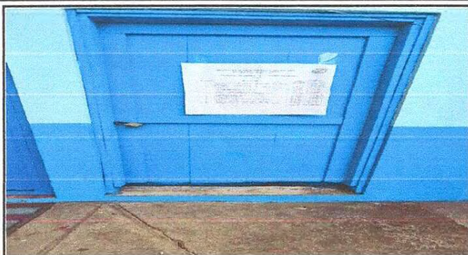
Foto 1: Sustrucción de puerta principal de madera a metal en módulo de bodega de 0.84m x 1.97m
