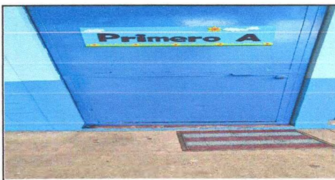
Foto 5: Sustitución de puerta principal de metal en módulo 1 de 1.035m x 2.04m
