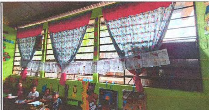
Foto 2: Sustitución de estructura de metal de 6 ventanas a pvc de 2.30 m x 1.80 m
