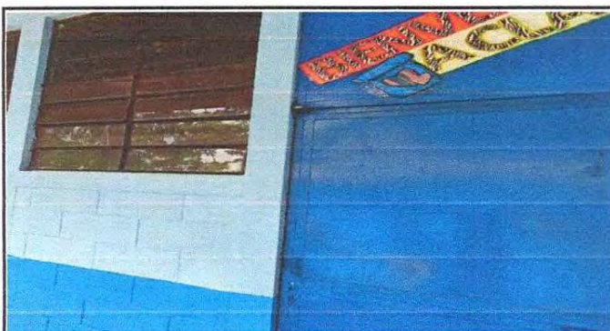
Foto 3: Sustitución de estructura de metal de 2 ventana a pvc de 1.15m x 1.40m
