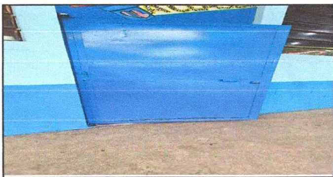
Foto 6: Sustitución de puerta principal de metal en módulo 1 de 1.035m x 2.04m
