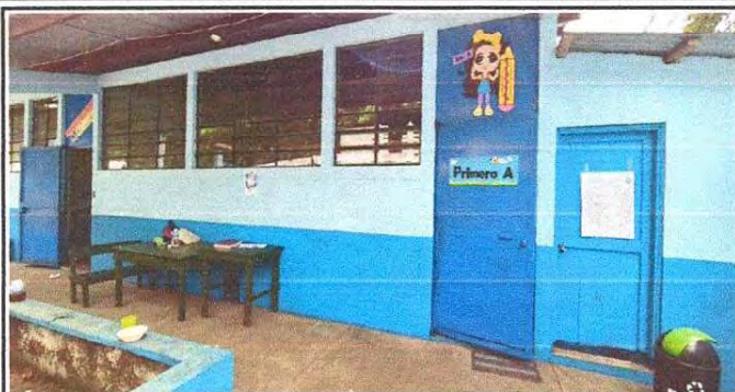
Foto1: Sustitución de estructura de metal de 4 ventanas a pvc de 2.30 m x 1.40m
