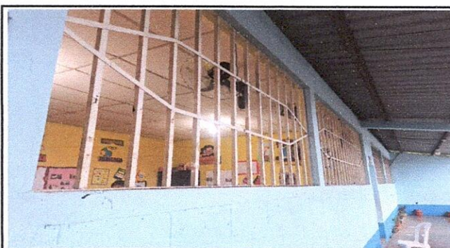
Fotografía 5: Mantenimiento de balcones de metal de aulas 1, 2, 3, 4, 5, y 6 del segundo nivel (incluye lijado y aplicación de pintura anticorrosiva a dos manos)
