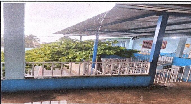
Fotografía 9: Suministro de canal Aluzinc cal. 26 en techo de gradas
