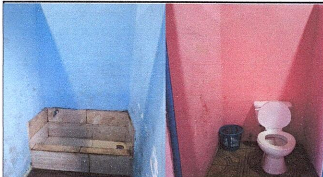
Fotografía2: Suministros de azulejo en modulo de baños
