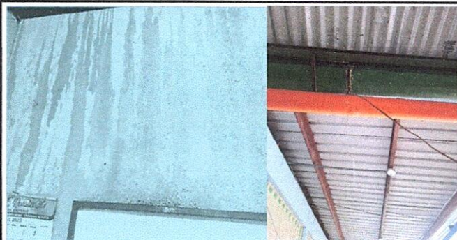
Fotografía 7: Sustrucción de canal por canal Aluzinc cal. 26 para aguas pluviales en Aulas 4,5 y 6
