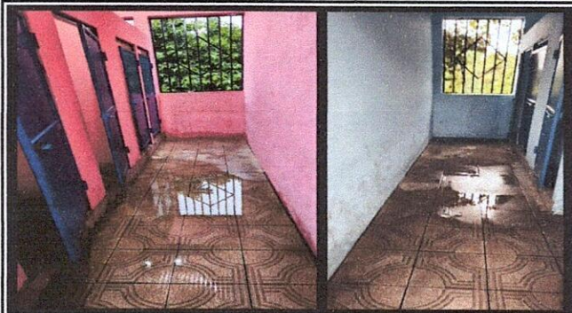
Fotografía 1: Suministros de pisos en modulo de baños
