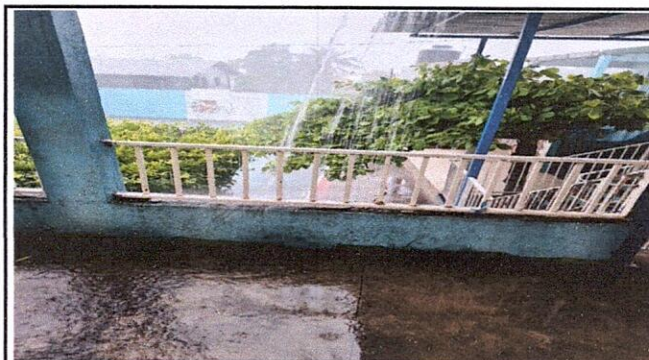
Fotografía 10: Suministro e instalación de tubo Ø 3" PVC para bajada de agua de techo de gradas
