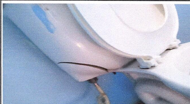
Fotografía 3: Sustitución de inodoros en baño de niños
