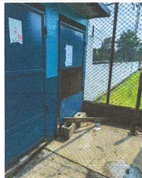
Foto 6: Mantenimiento de puertas de Sanitarios.
