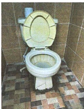
Foto 3: Cambio de sanitarios en mal estado.
