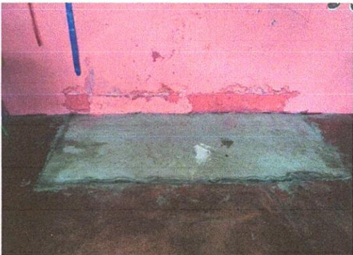
Foto 1: Sustrucción de piso por piso cerámico en los salones del nivel preprimario.
