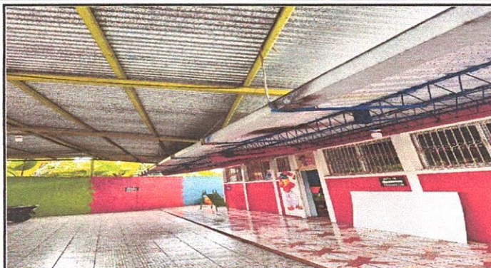
Foto7 Renglón 4.1 : Suministro e instalación de canal de metal
