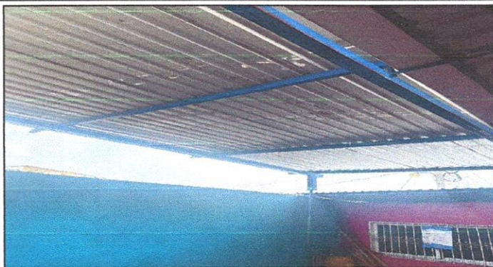
Foto 2: Renglón 1.2: Sustitución de estructura de soporte de lámina (dirección, incluye mano de obra)
