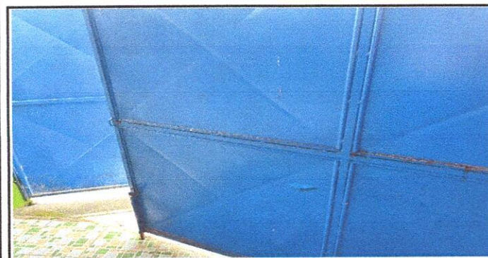
Foto 5: Renglón 3.1: Sustitución e instalación de portón principal de 2 hojas con puerta peatonal. Medidas 3.12 x 2.60 metros
