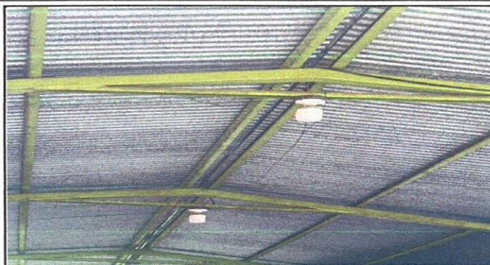
Foto 1: Renglón 1.1: Mantenimiento y servicio a estructura de soporte de lámina e instalación de lámina troquelada (corredor)
