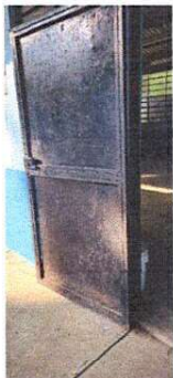
Foto4: Suministro e instalacion de puerta de metal
