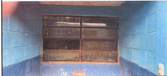
Foto 2: Suministro e Instalación de Ventanas
