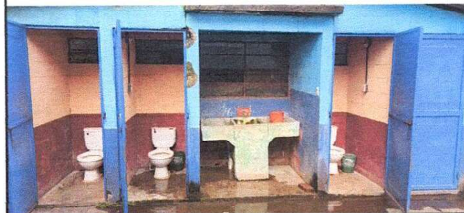
Foto 7: Sustitución de Sanitarios (incluye accesorios)
