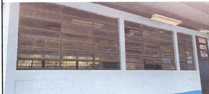
Foto 2: Suministro e Instalación de Ventanas
