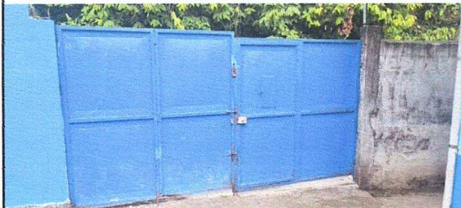
Foto1: Mantenimiento de Portones
