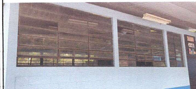
Foto 3: Suministro e Instalación de Ventanas
