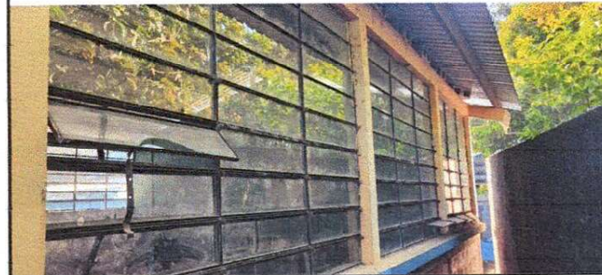
Foto 3: Suministro e Instalación de Ventanas
