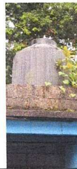
Foto 7: Suministro sustitucion de deposito de agua
