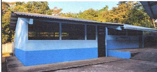
Foto 5: Suministro y mantenimiento de lamina Troquelada calibre 26
