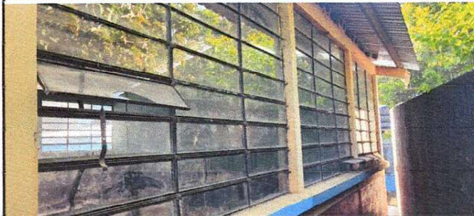
Foto 2: Suministro e Instalación de Ventanas
