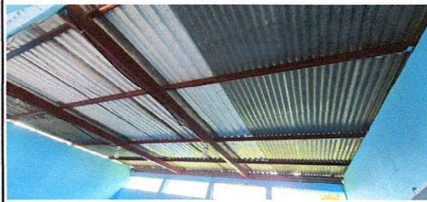
Foto 2: Sustitución de lámina, por lámina troquelada aluzinc calibre 26.
