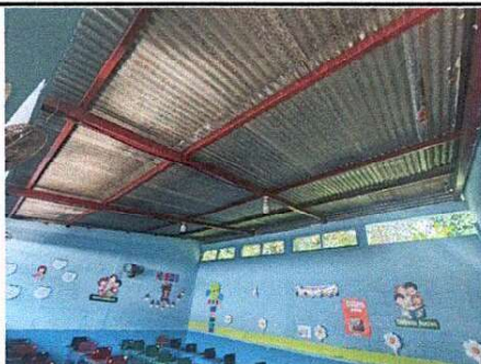
Foto 3: Mantenimiento a estructura de soporte de metal
