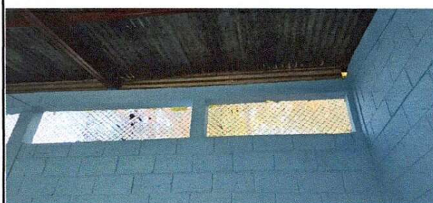
Foto 4: Mantenimiento a estructura de soporte de metal
